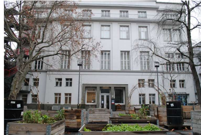
Gebäude I Villa von 1905 mit Garten im Innenhof
